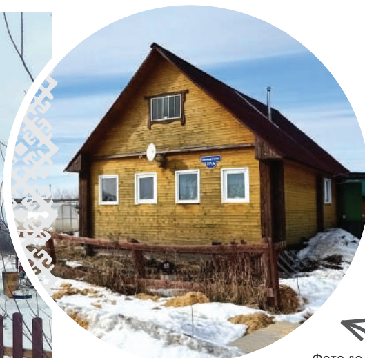
Фото до ремонта
