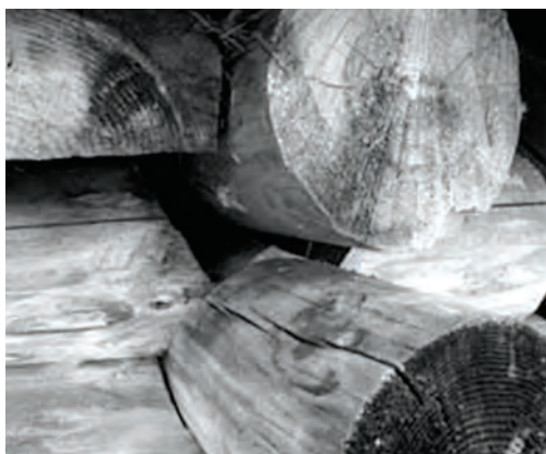
Ил. 5. Геометризованный треугольный валик в основании чаши на срубе хлева в д. Илекинская Каргопольского района Архангельской области
