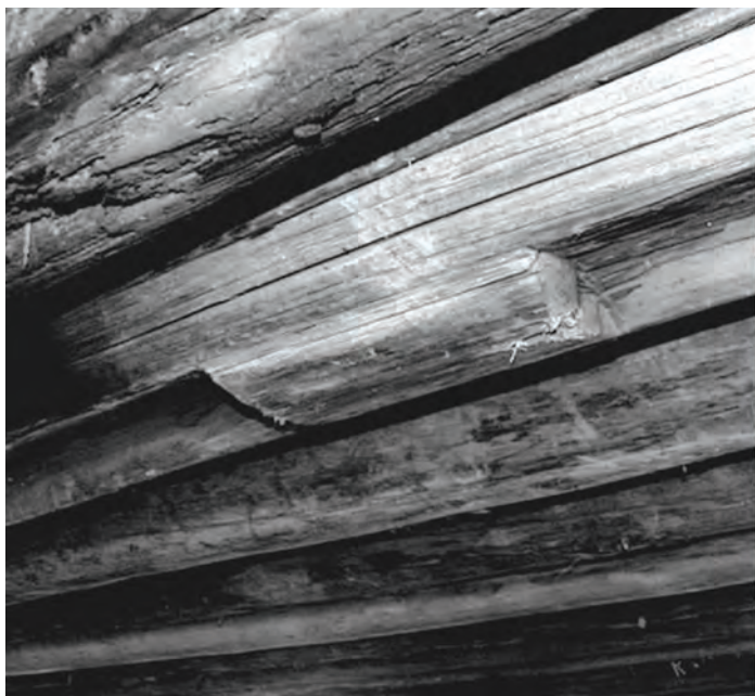
Ил. 4. Устройство «засека» на бревнах Успенской часовни конца XVII века в д. Васильево на острове Кижь. Фото А.Ю. Косенкова
