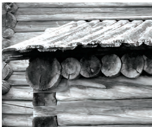
Ил. 6. Покрытие хлева в виде сплошного наката из бревен с боковой припазовкой в д. Морщихинской Каргопольского района Архангельской области
