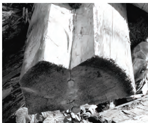
Ил. 3. Треугольный продольный паз на руинированной постройке в д. Карпово Плесецкого района Архангельской области
