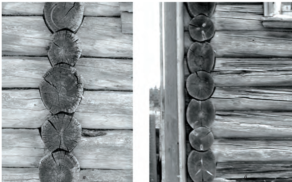
Ил. 1. Припазовка бревен в срубе: а – нижняя, б – двойная. Фото А.Ю. Косенкова
