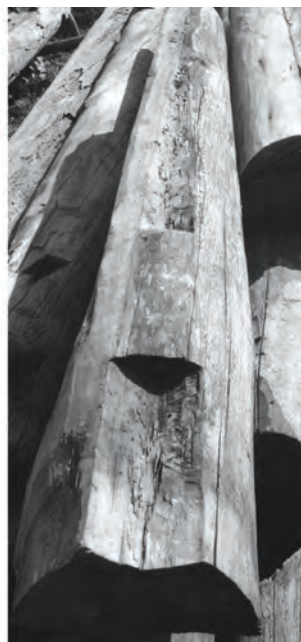
Ил. 4. Устройство «засека» на бревнах Успенской часовни конца XVII века в д. Васильево на острове Кижь. Фото А.Ю. Косенкова
